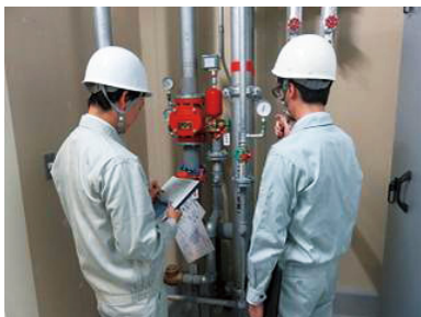
現地調査の様子
